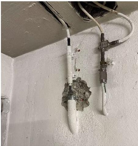
5 Der Bereich um die 1-Zoll-Einführung wird in der Grösse der Halbschale der neuen Abdichtung freigespitzt
