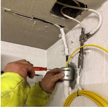
8 Die neue Abdichtung wird mit der zweiten Halbschale verschraubt
