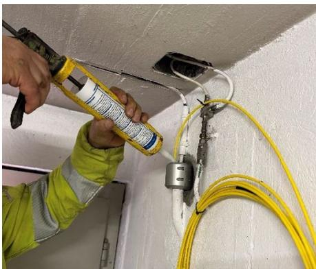
9 Die neue Abdichtung wird mittels Einkomponenten-Dichtmasse gefüllt. Die Mindestabstände zwischen Kabeln und Aussenwand sind einzuhalten
