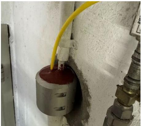
10 Die Dichtmasse muss aushärten, bevor das Kabel weiterverarbeitet werden kann
