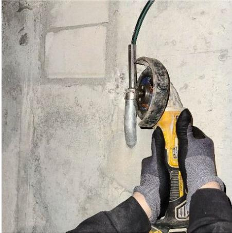
4 Der restliche Teil der Abdichtung wird aufgeschnitten, um die 1-Zoll-Einführung komplett freizulegen. Achtung: Das bestehende Kabel ist gegen Beschädigung zu schützen!
